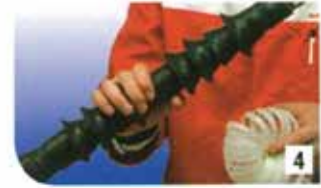
4 Proses instalasi terminasi sudah selesai
